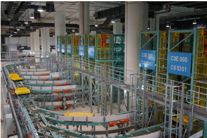
Hochregallager des EBS-Systems
