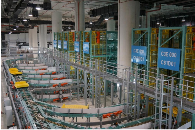
Hochregallager des EBS-Systems
