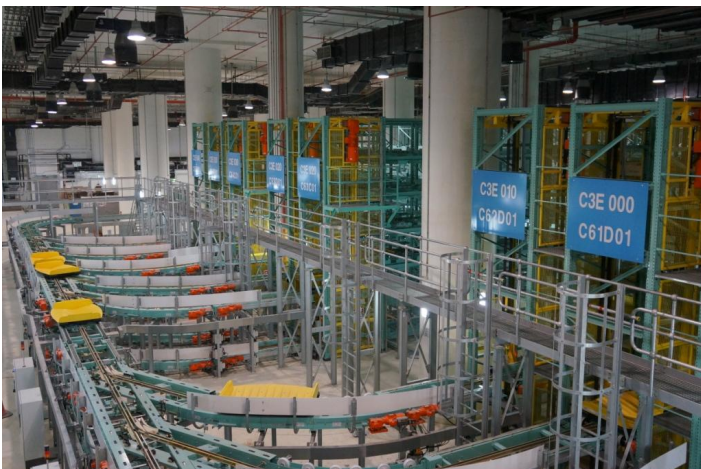
Hochregallager des EBS-Systems
